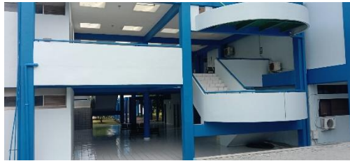
Gambar 1. Gedung Perancangan Mekanik
